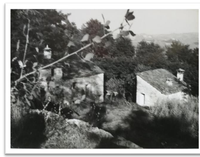
Ruderi. Quello a sinistra è attualmente l'edificio della reception e appartamenti residenti. A destra l'attuale casa di Gianni.
