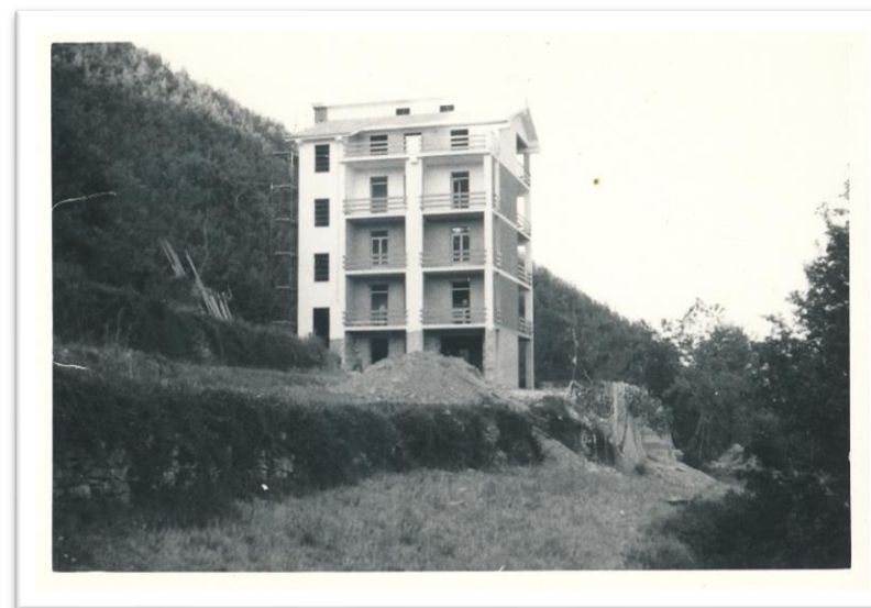
La Meridiana in costruzione
